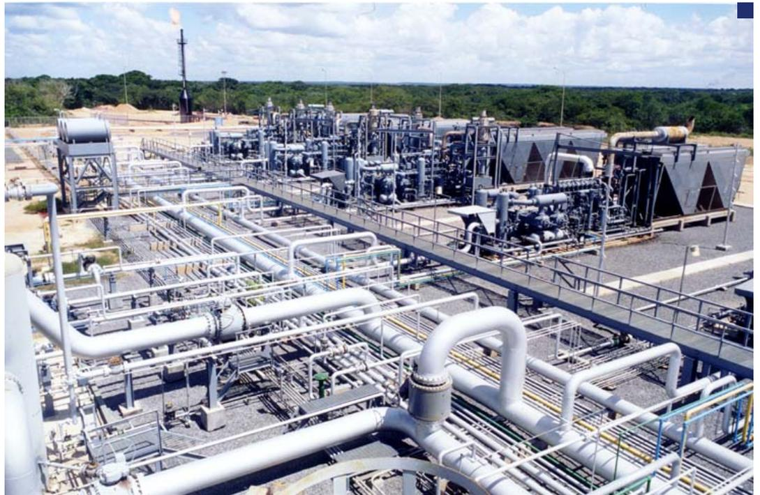
Skanska LA realizó la ingeniería, procura, construcción y puesta en marcha de 6 compresores de gas (3 de Gas de Inyección y 3 Duales).
